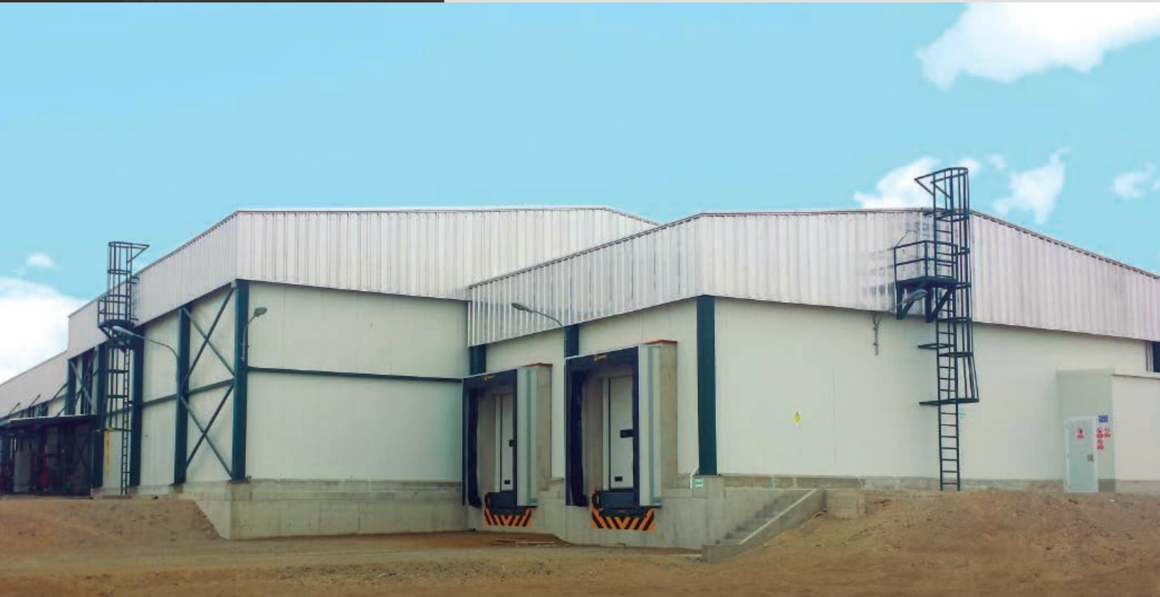
Suministro, fabricación y montaje de estructuras metálicas emperradas. Tijerales y columnas de tubos laminados. Instalación de cobertura aluminio PV4 espesor 0,6mm.
