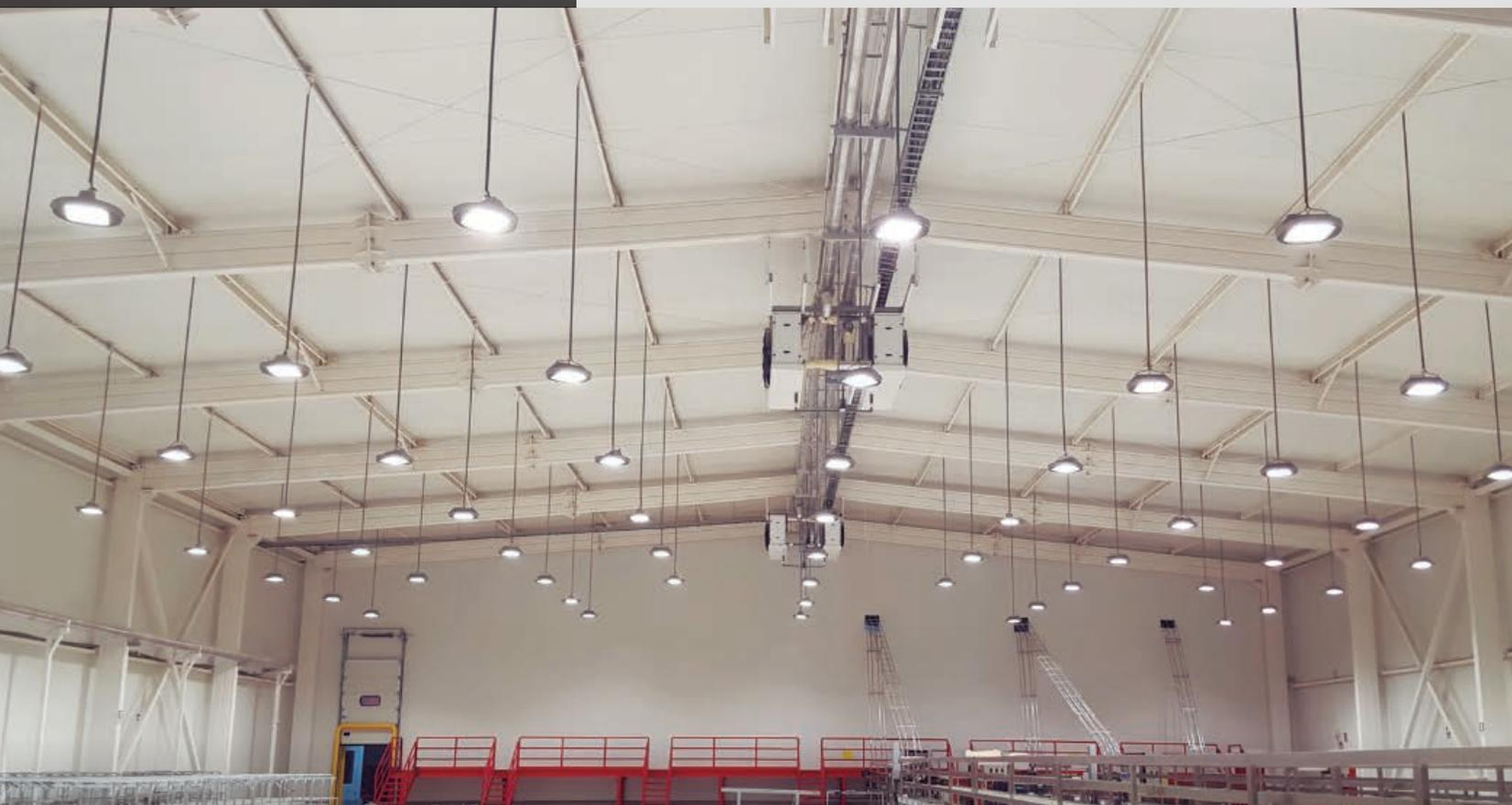
Suministro, fabricación y montaje de estructuras metálicas emperradas con sistema Tubest. Instalación de coberturas metálicas panel tecnotecho PV4 y policarbonato traslúcido.
